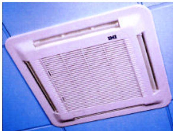
Fig. 23 – Ventiloconvector tipo cassette
