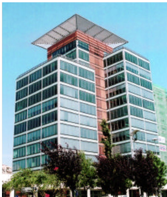
Fig. 13 – Edifício de Escritórios
